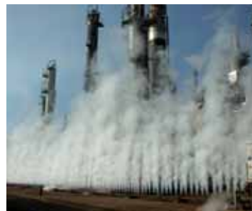
Un rideau de vapeur pour empêcher que les gaz ne se répandent en cas de fuite.
